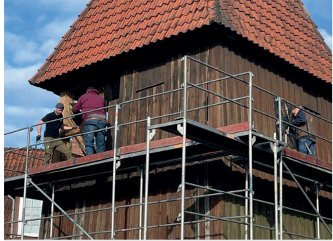
Der Abriss beginnt
