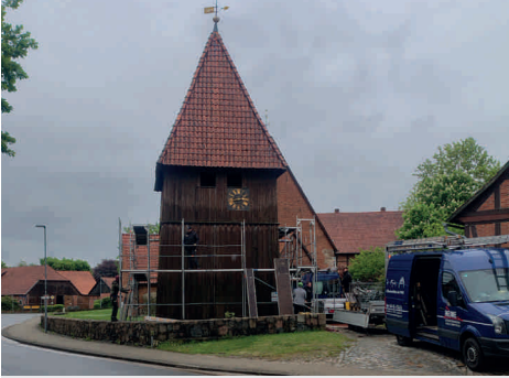
der „alte“ Turm wird eingerüstet
