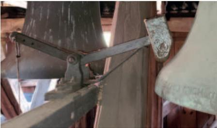
Und warum funktioniert das in Hohnhorst? Das verrät uns das Foto rechts. Hier schlägt die Uhr auf eine Schale (links). Die Glocke (rechts) kann frei schwingen, auch wenn die Uhr gerade die Uhrzeit schlägt.
